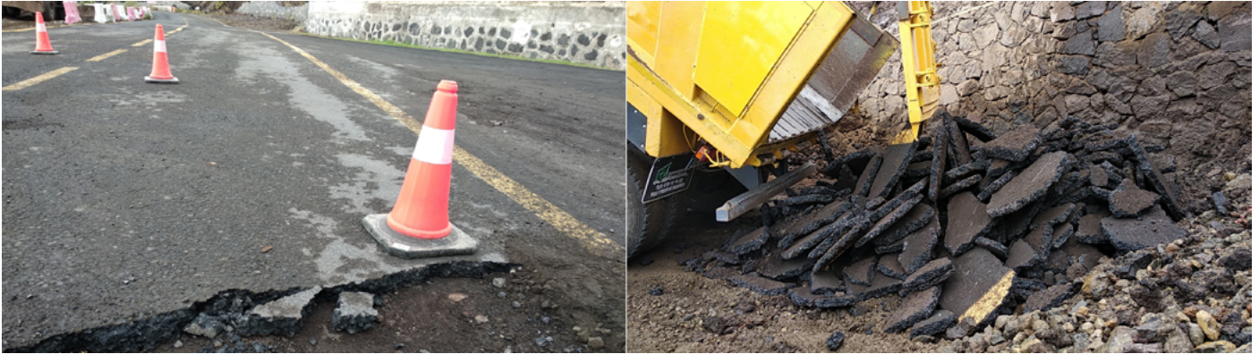
Figura 1: Demolición mecánica de un firme bituminoso. (Fuente: Sacyr)
