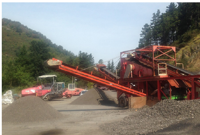
Figura 4: Tratamiento de cribado del RAP en dos fracciones. (Fuente: Asfaltia)
