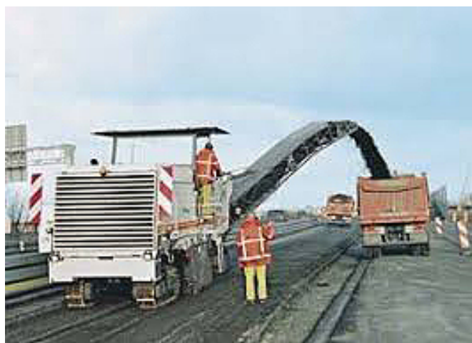
Figura 3: Fresado en profundidad.
