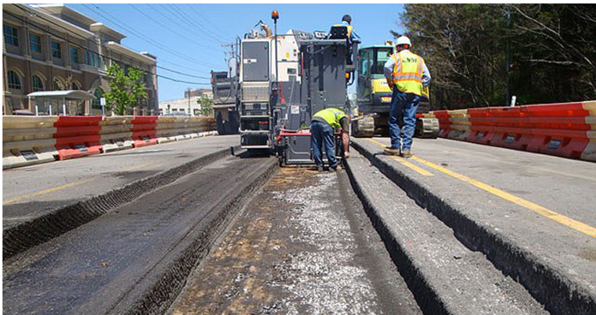
Figura 2: Fresado por capas.
