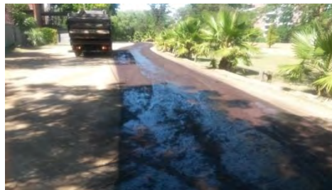
Figura 12. Riego con Camión
