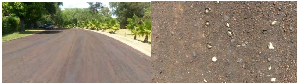
Figura 13. Riego de Imprimación finalizado.
