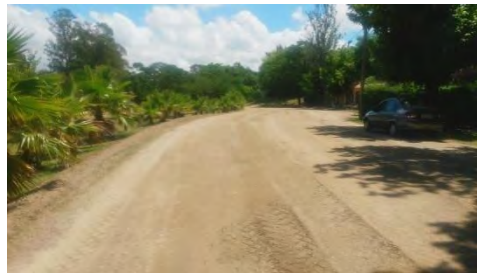
Figura 11. Base de granular
