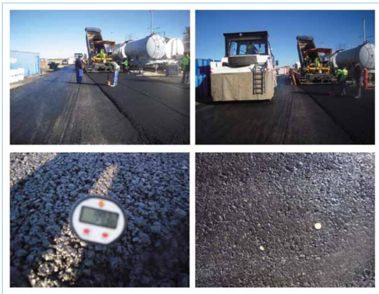
Figura 1: Fotografías del tramo de prueba inicial para testificación y retroanálisis (Octubre 2010).
