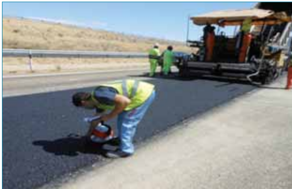
Figura 14. Extendido de la capa de base MBT AC22 con 50% RAP.
