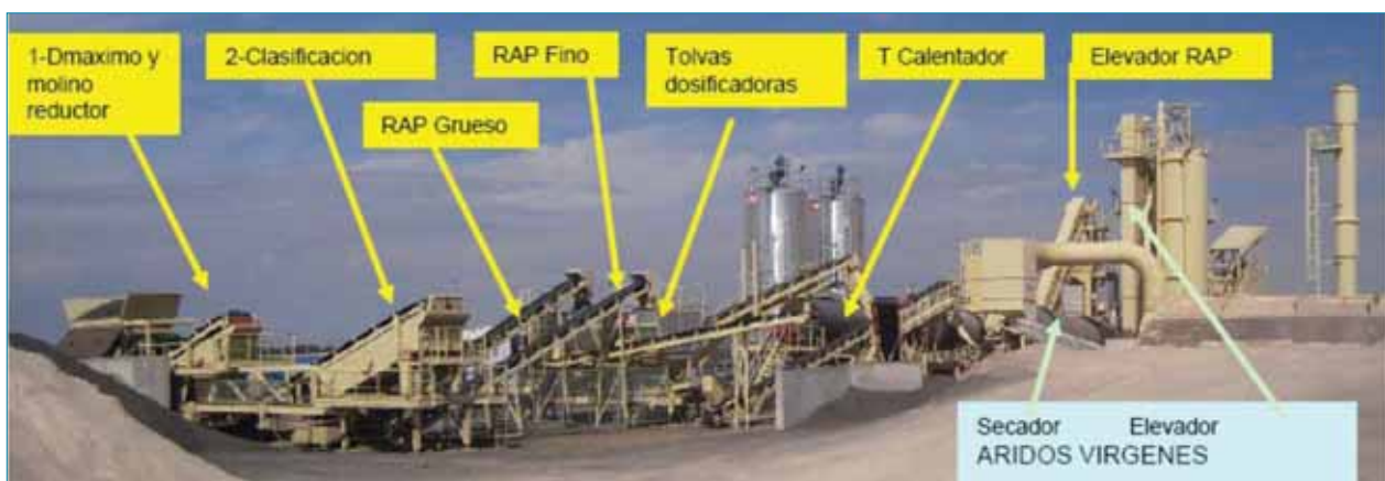
Figura 5- Panorámica del sistema de pretratamiento y proceso del RAP.
