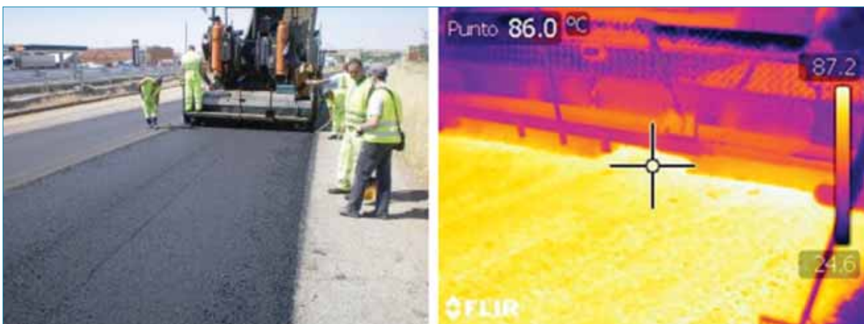
Figura 10: Extendido de la MBT R100 en la capa intermedia de reposición y Termograma de la mezcla a salida de regla.
