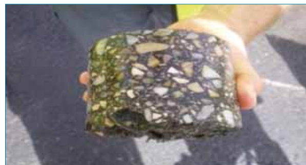
Foto 12: Testigo de obra con MTRE a tasa total.
