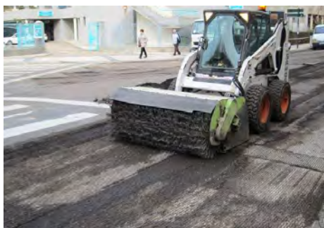
Figura 9. Detalle del barrido de una superficie fresada. Fuente blog Motores y Carreteras
