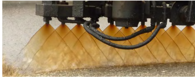
Figura 11. Detalle de los abanicos del riego de adherencia. Fuente web de IBEF.
