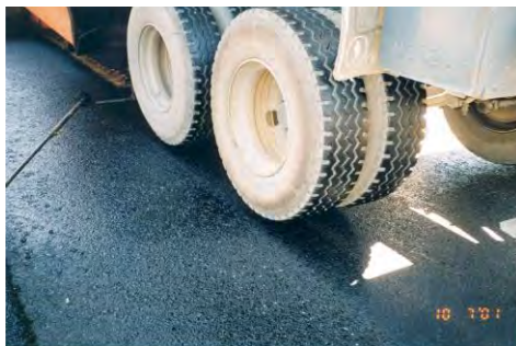
Figura 8. Aplicación de mezcla en caliente sobre emulsión termoadherente
